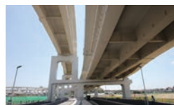
横浜港北ジャンクション： 土木学会田中賞（作品部門）
