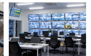
同工場のコントローラー室
