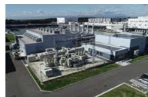
完成した清原スマートエネルギーセンター（栃木県宇都宮市）
