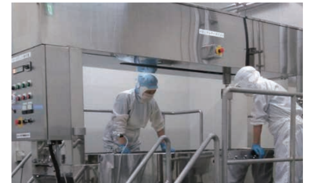
小規模プラント試運転作業(カード攪拌・ホエイ除去設備)
