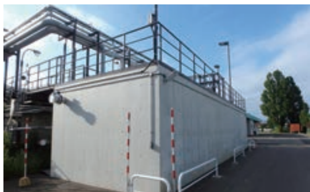
排水処理設備(札幌工場)
