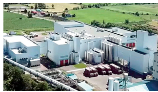
磯分内工場全貌 (主に、バター、脱脂粉乳、生クリームを生産)
