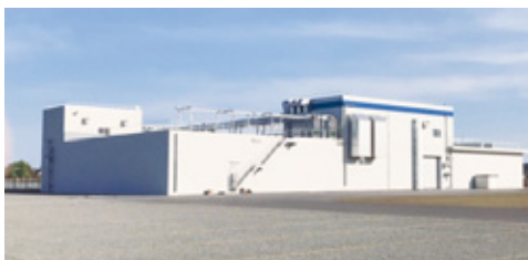
排水処理設備(大樹工場)
