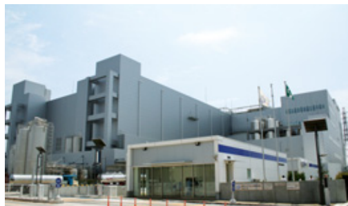
海老名工場外観
