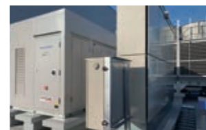
日本デリーネット(株)名古屋第二センター ノンフロン冷蔵冷凍装置
