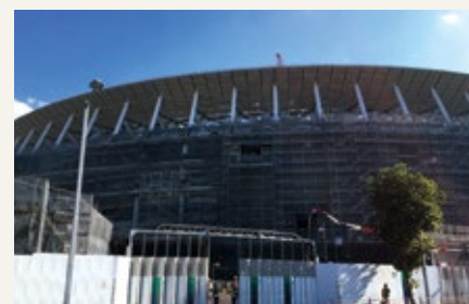
建設中のオリンピックスタジアム
