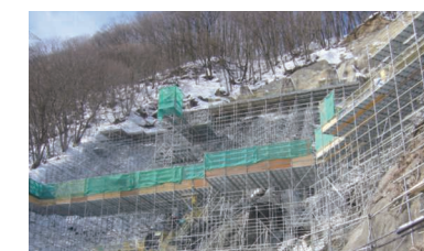
斜面に設置可能で構台にもなるシステム足場「YTロックシステム」
