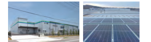
伊藤園神戸工場での太陽光パネルの設置(2023年1月設置)
