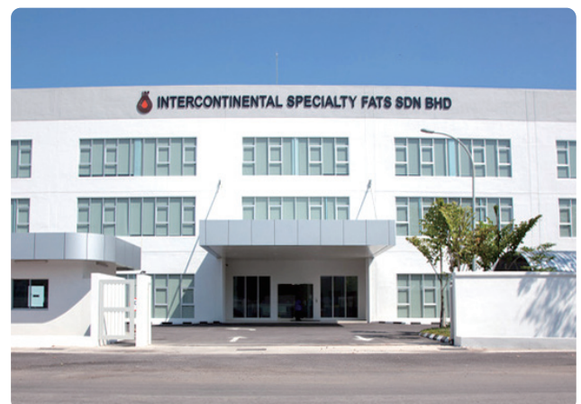
ISF ポート克蘭工場(マレーシア)
