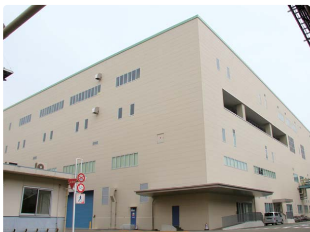
▲ 横浜磯子事業場に新設した食品第三工場
