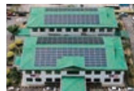
マレーシアISF社の太陽光パネル
