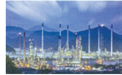
高度防火システム (石油化学プラント)
