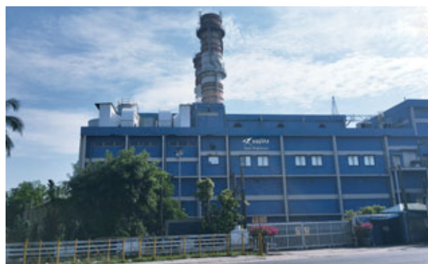
スリランカ 複合火力発電所
