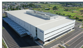
つくば物流センター外観
