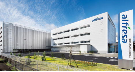
東北アルフレッサ(株)仙台本社 外観
