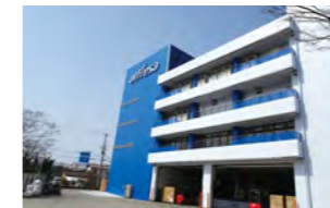
自動倉庫の導入により商品格納能力が向上したアルフレッサ ヘルスケア(株)の関西物流センター(2019年3月改修完了予定)
