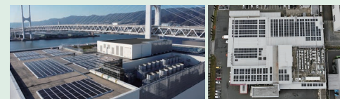
キューピー神戸工場(左)、 キタカミデリカ(右)の屋上 に設置した太陽光パネル
