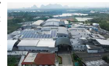
太陽光発電を導入したキューピータイランド
