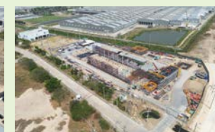
2023年2月(床・壁施工)
