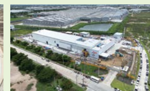
2023年6月(工場棟屋根・内装施工)
