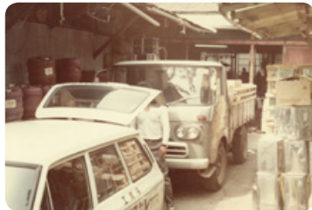
松見町の本社・工場
