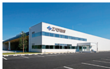
栃木物流センター
