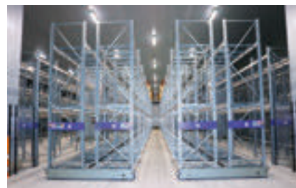
倉庫内 移動ラック
