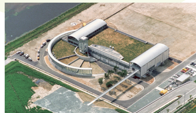
静岡ファクトリー第1棟竣工
