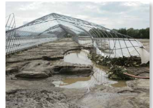
倒壊したビニールハウス
