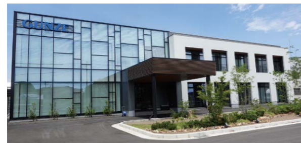
ZEB 認証新事務所 (江南工場)
