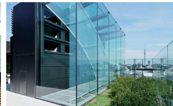
自然換気システム（屋上のソーラーチムニー）
