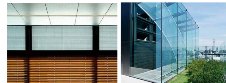
自然採光システム (窓の上部)
