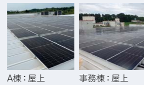
A棟：屋上 事務棟：屋上
