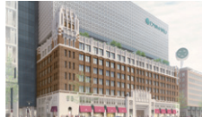
大丸心斎橋店新本館
