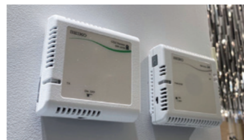
伊勢丹新宿本店 環境測定センサー 【左】CO 2 センサー 【右】温湿センサー
