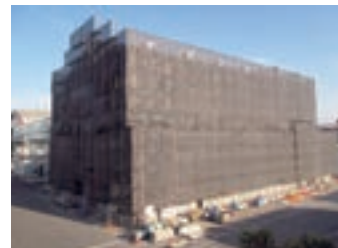
建設中の柳井第4工場建屋
