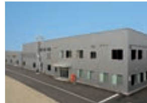
小坂井新テンプレート工場建屋
