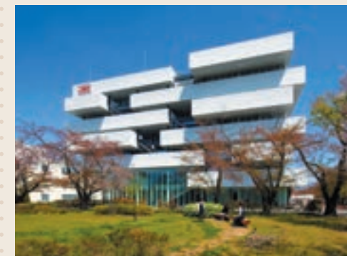
日本無線㈱先端技術センター
