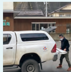
復旧対応の様子
