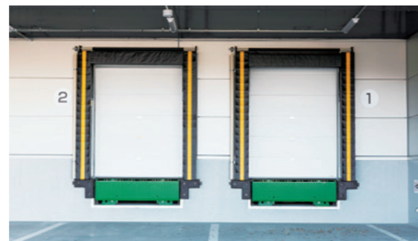
商品を外気に触れさせないためのドッグシェルター
