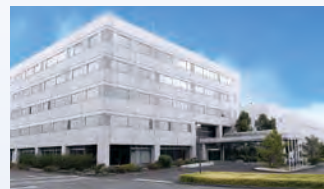
掛川センター
