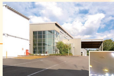
▲敷地面積 約11,000坪の物流拠点
