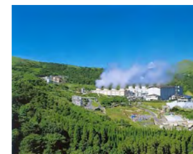
日本最大の地熱発電所:八丁原発電所(大分県)
