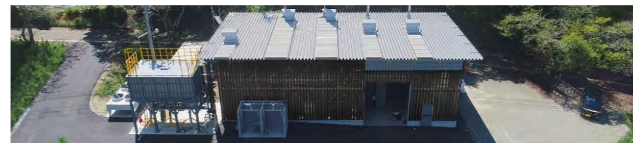
内子龍王バイオマス発電所
