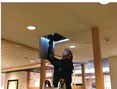
360 度カメラを活用した天井裏点検の様子
