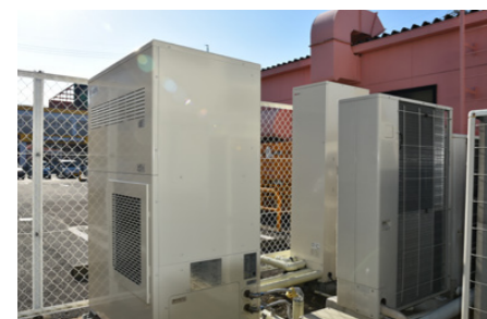
パーミヤン静岡国吉田店に導入した業務用燃料電池(左側および右奥)
