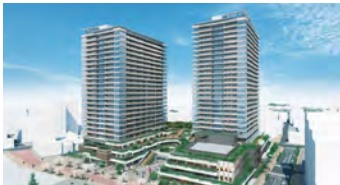
武蔵小金井駅第2地区再開発
