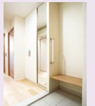
段差を解消し、ベンチや手摺を設置した玄関
