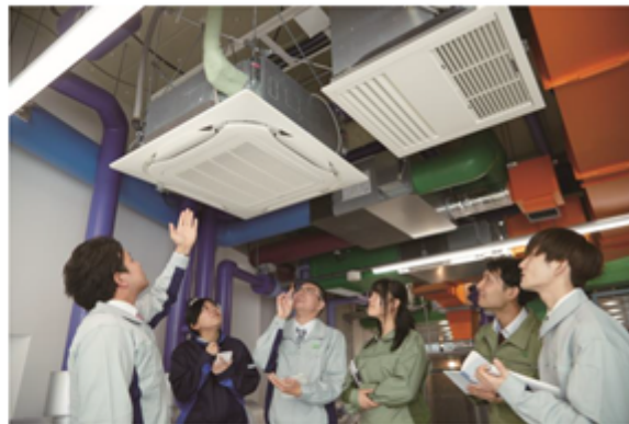
設備実習フロア
