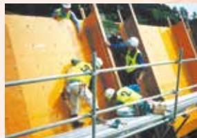
高い強度を持つ アラミド繊維は土木現場でも 補強材として活躍
