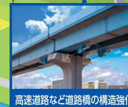
高速道路など道路橋の構造強化
