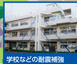
学校などの耐震補強
