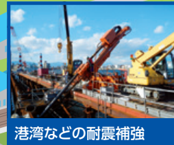
港湾などの耐震補強
