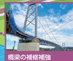
橋梁の補修補強
