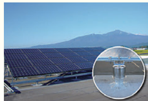
太陽光パネルの架台取付けに
