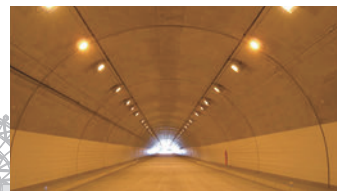
トンネル内の照明の固定
