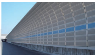
高速道路の遮音壁の固定
