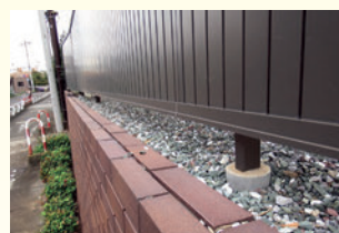
フェンスの取付けに
