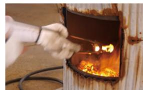
従来：コークスで高温に加熱したリベットを作業者に投げ渡すといった熟練の作業が必要
