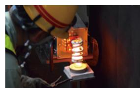
新工法：加熱コイルでスピーディーに加熱し、打設場所までの距離も短くできるため、高温のリベットを投げ渡す必要がなく、作業効率と安全性が向上
