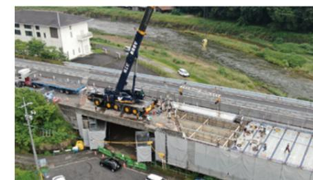
独自の継手工法「KK合理化継手」を使用した床版取替工事
