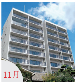
11月 福岡エリアで 新築マンション竣工
